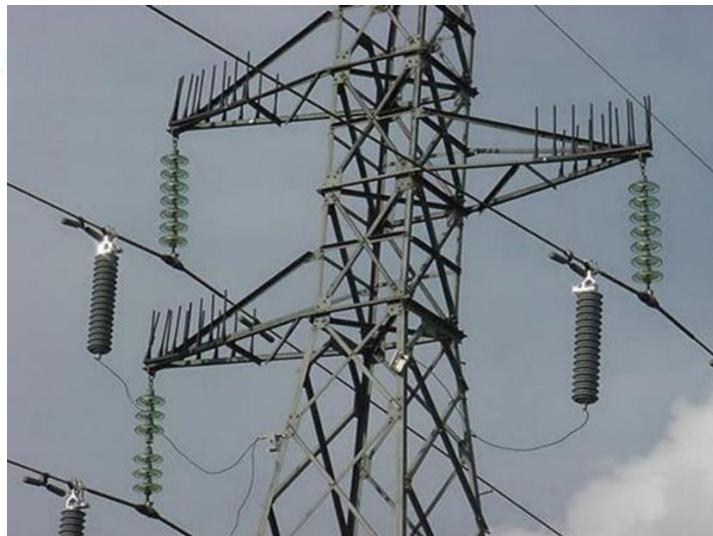
Slika 27. prikaz voda štićenog odvodnicima prenapona
